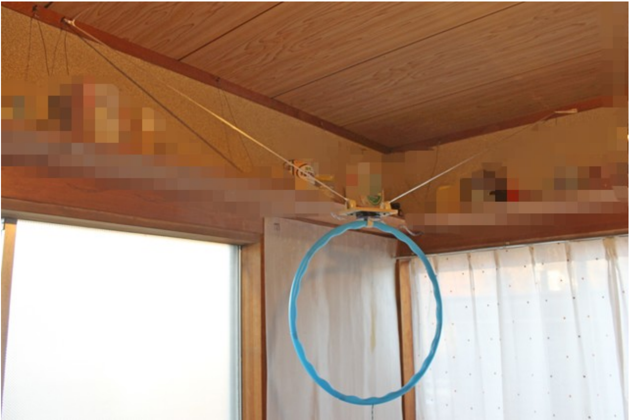
上写真 ヒートンを廻り縁に取り付けて2本のヒモで吊り下げた例
